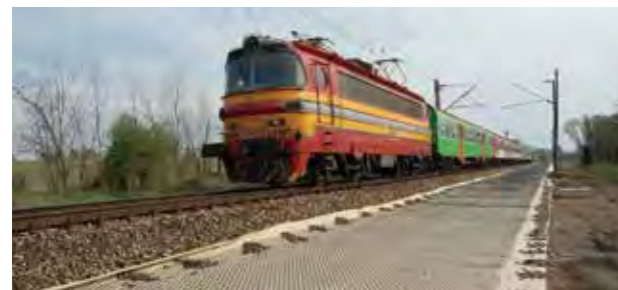
在软弱地基上利用坦萨TriAx®三向土工格栅®进行力学加固道砟底层重建轨道(斯洛伐克·布拉迪斯拉发)
