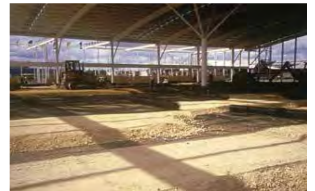
LTP支撑于门式钢架结构厂房混凝土底板下方 (英国)
