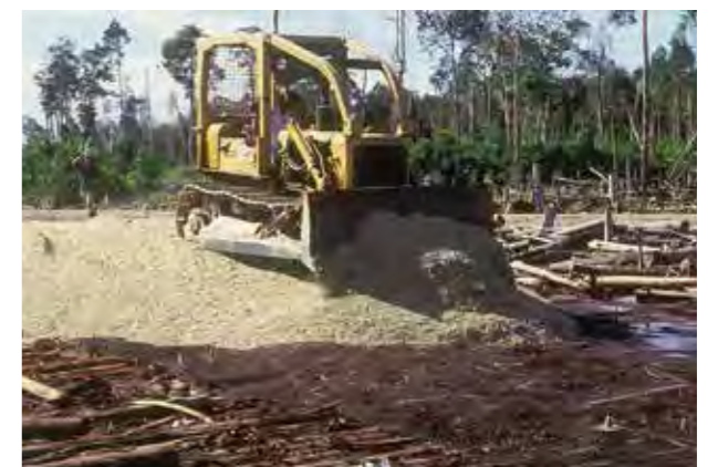
泥炭土地上采用LTP修建道路 (印度尼西亚)
