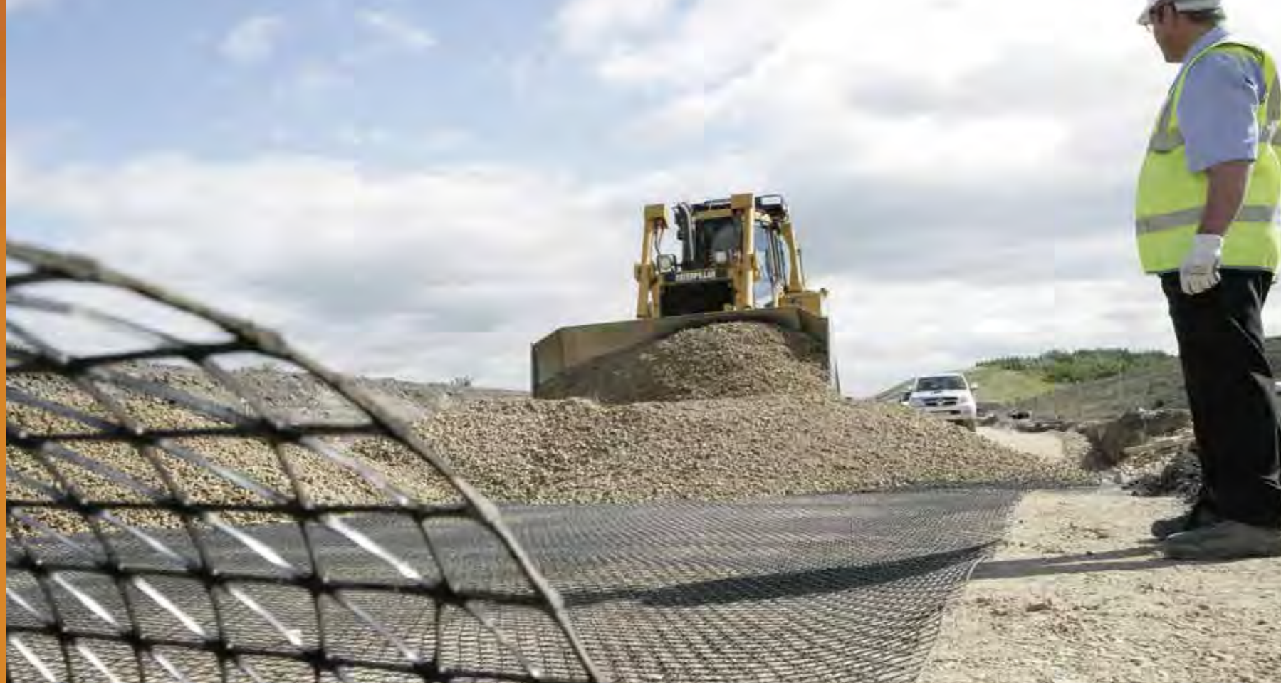
TriAx® 三向土工格栅® 改善了粒料的侧限约束和有效嵌锁, 增强了力学稳定层的结构性能
