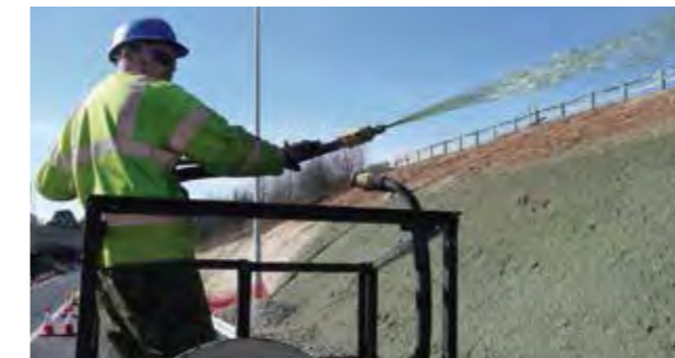
HydraMax侵蚀控制系统用于英国M25高速公路
