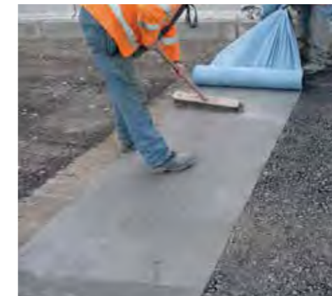
Glasstex®Patch™880 可利用粘合层粘在大部分基层上
