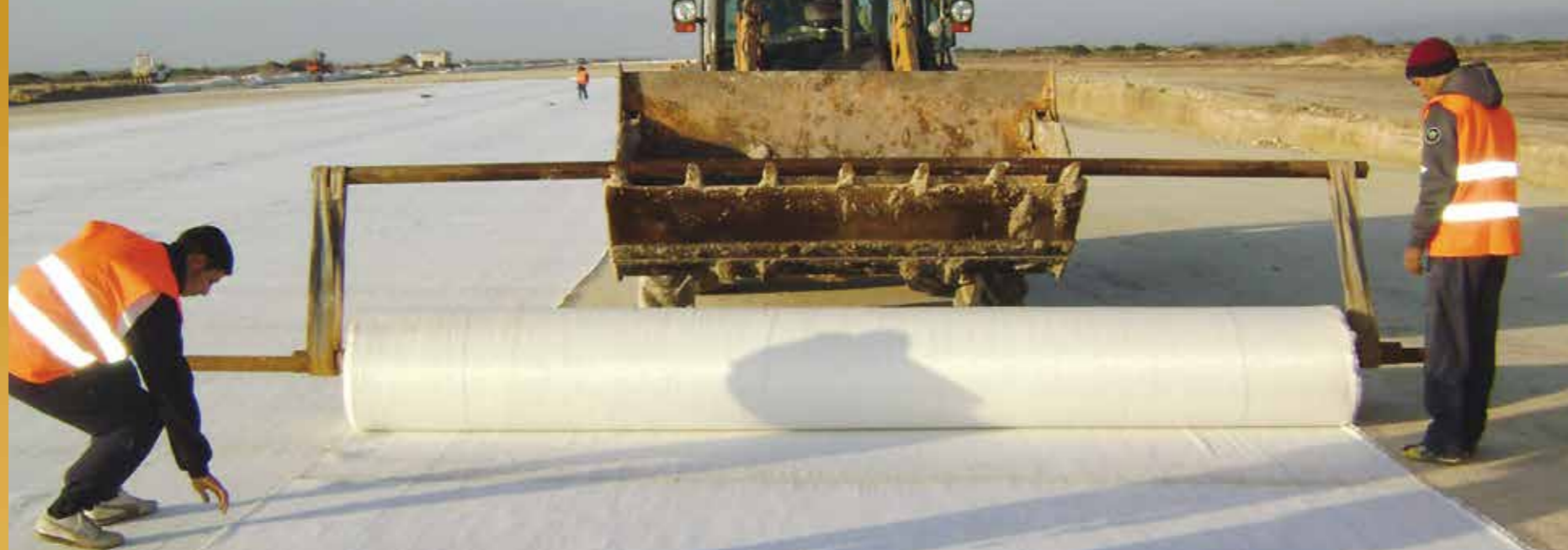
阿尔及利亚奥兰机场坦萨Basetex™的铺设，为填料下方提供了一层高强加筋材料，从而形成一种经济性极好的施工方案。
