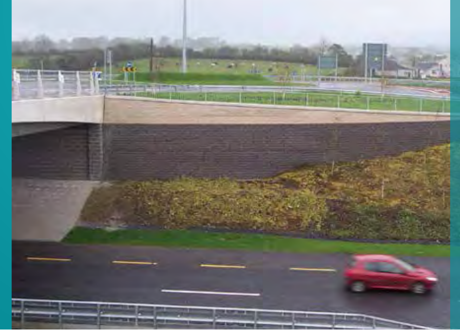
TensarTech® 挡墙系统——桥梁翼墙上多彩的面板，具有生动的效果
