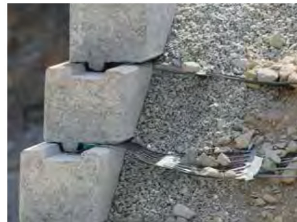
所有TensarTech® 挡墙系统的共同特色是土工格栅与面板之间高效的连接方式，图例为TW1 挡墙系统
