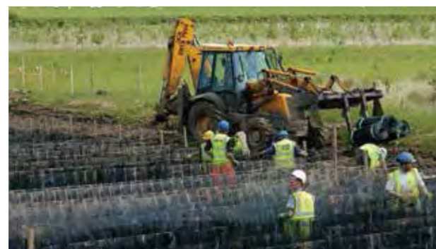
TensarTech® Stratum™ 蜂窝状基础筏垫系统用于控制多变地基于的不均匀沉降
