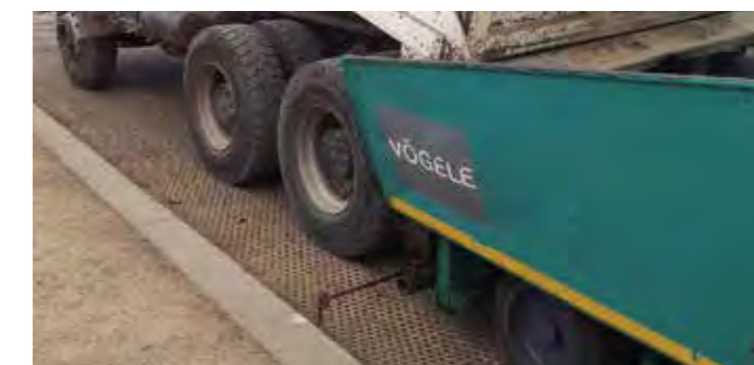
采用坦萨TriAx®加固的铺面可以最大程度地避免道路结构恶化, 维持整个结构的特性
