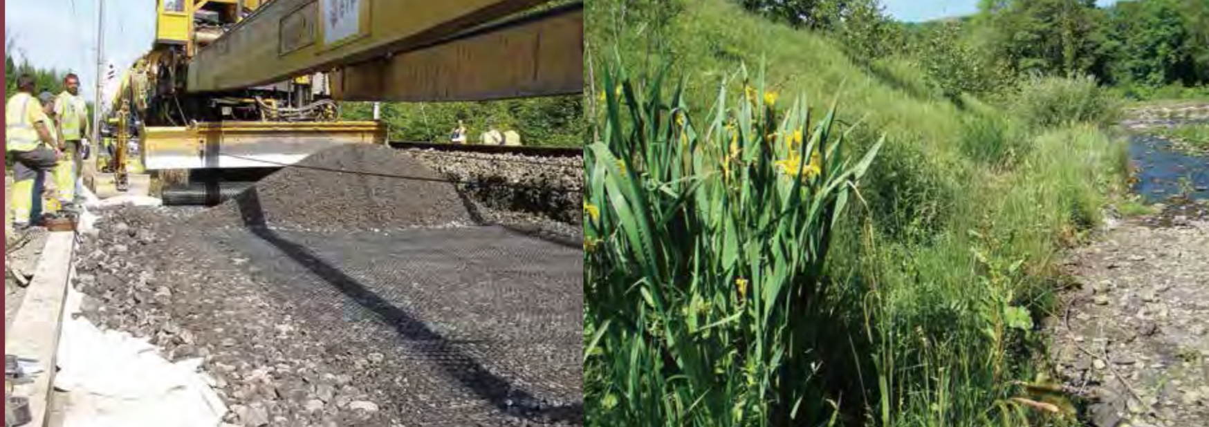
坦萨TriAx®三向土工格栅®铺设于底层道砟碎石层下,以提高地基承载力(比利时)
