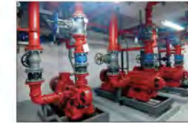
地铁泵房除味
