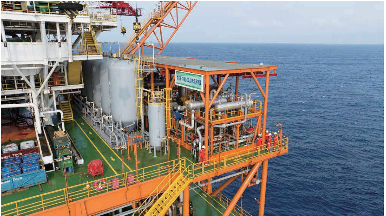
恩平 15-1 油田平台上的 CO 2 处理回注模块，广东珠江口盆地（照片来源：中国海油）。
