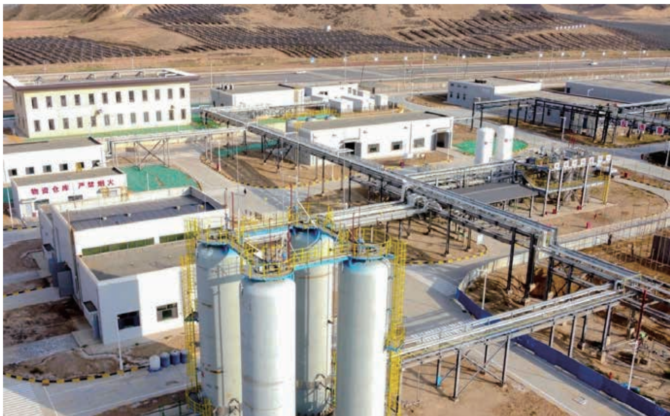
二氧化碳加氢制甲醇“液态阳光”示范项目，甘肃兰州
